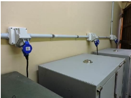
Figura N° 15: Nuevos tomas y Vista parcial instalación eléctrica para estufas de secado. Figura N° 16: Freezers para conservación de muestras vegetales
