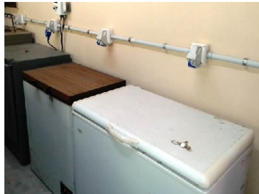
Figura N° 15: Nuevos tomas y Vista parcial instalación eléctrica para estufas de secado. Figura N° 16: Freezers para conservación de muestras vegetales
