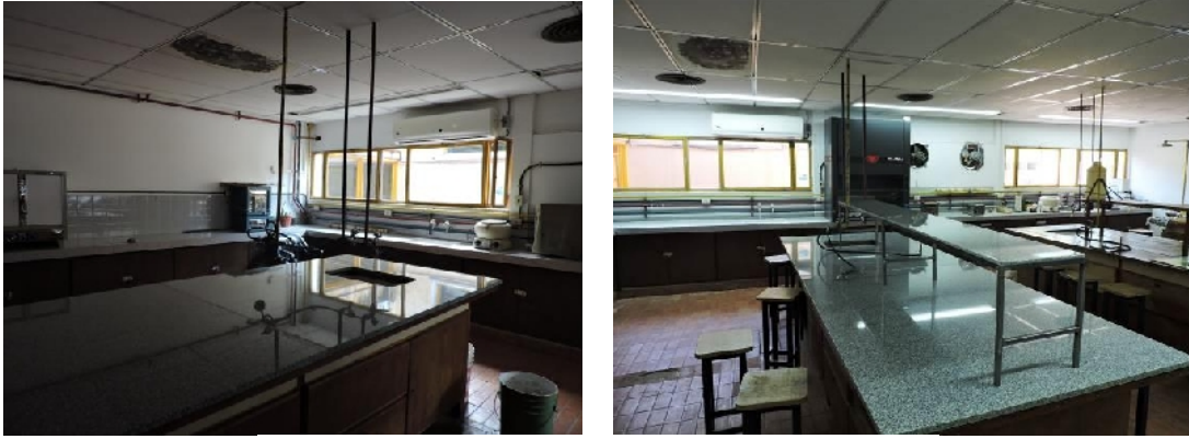
Figura N° 20 - Figura N° 21: Vista parcial nuevas mesadas
