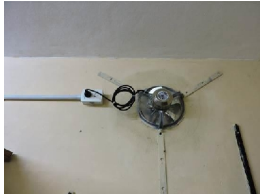
Figura N° 19 - Figura N° 20: Instalación de nuevas termocuplas y extractor de aire.
