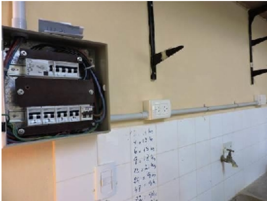
Figura N° 11 - Figura N° 12: Tablero de Distribución y vista parcial instalación eléctrica.
