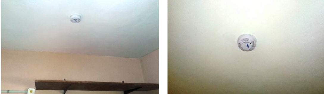
Figura N° 37 – Figura N° 38: Instalación de Detectores de humo.
