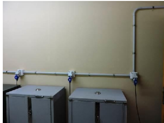
Figura N° 13 - Figura N° 14: Nuevos tomas y Vista parcial instalación eléctrica.
