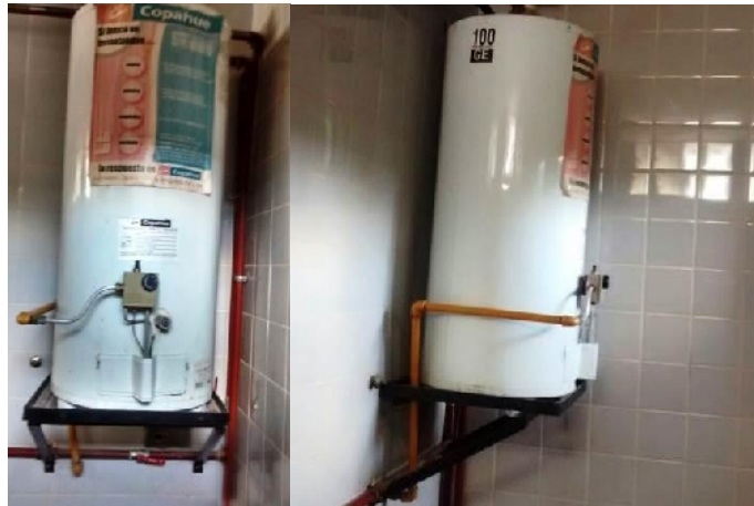
Figura N°8: Instalación y adecuación termotanque.
